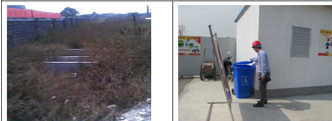
施工废水、垃圾收集图
